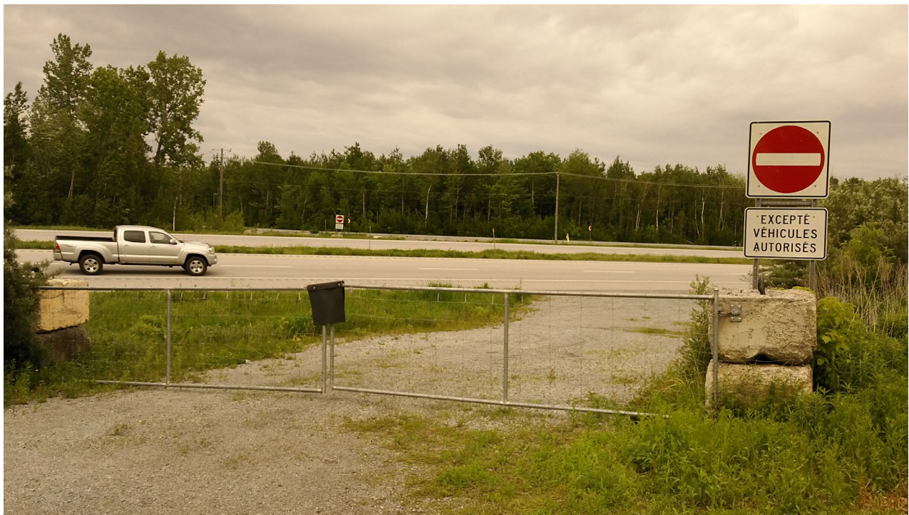
Figure 5. Absence de franchissement de l'autoroute 35 à l'intersection de la montée de la Station, Saint-Alexandre
