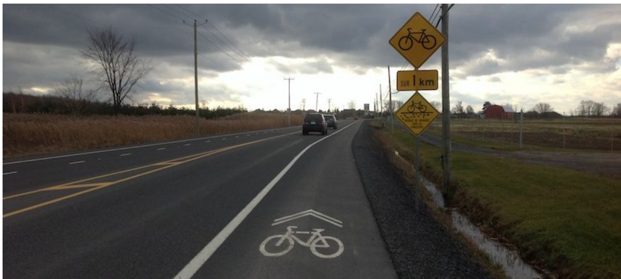
Figure 15. Exemple de marquage et de signalisation pour accotements asphaltés, Saint-Bruno-de-Montarville
